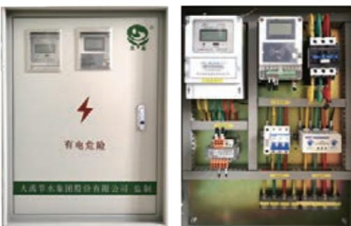
水电双计量机井灌溉控制柜是农业机井灌溉管理系统的核心设备，它将射频卡机井控制器、三相电能表、断路器、交流接触器、电机保护器、浪涌保护器及相应配电器件集成在一个箱体内，可实时采集灌溉用电量、用水量或灌溉时间并自动收取灌溉费用。
